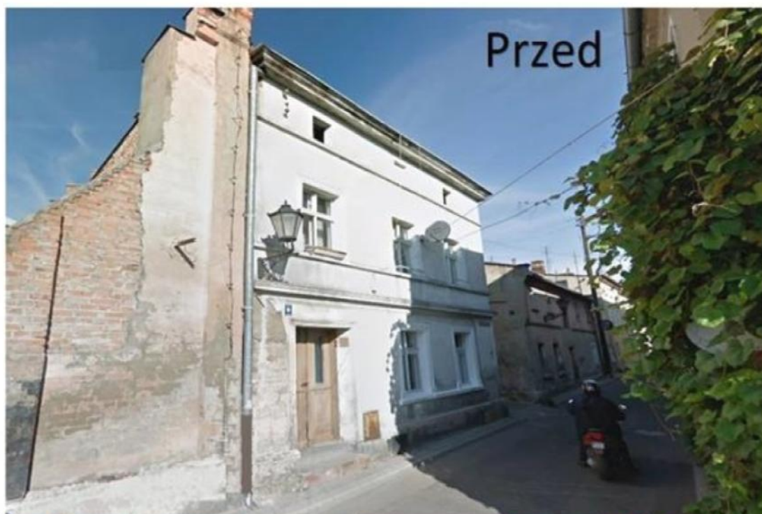
Wykonanie elewacji wraz z przebudową klatki schodowej w budynku komunalnym przy ul. Narutowicza 10 w m. Góra
