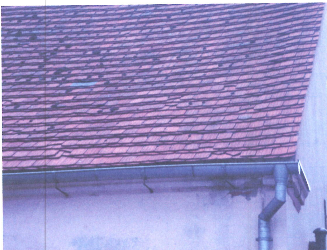
Fot. 3 Uszkodzenie gzymsu w narożniku budynku, dachówki na połaci dachowej uszkodzone i z ubytkami;
