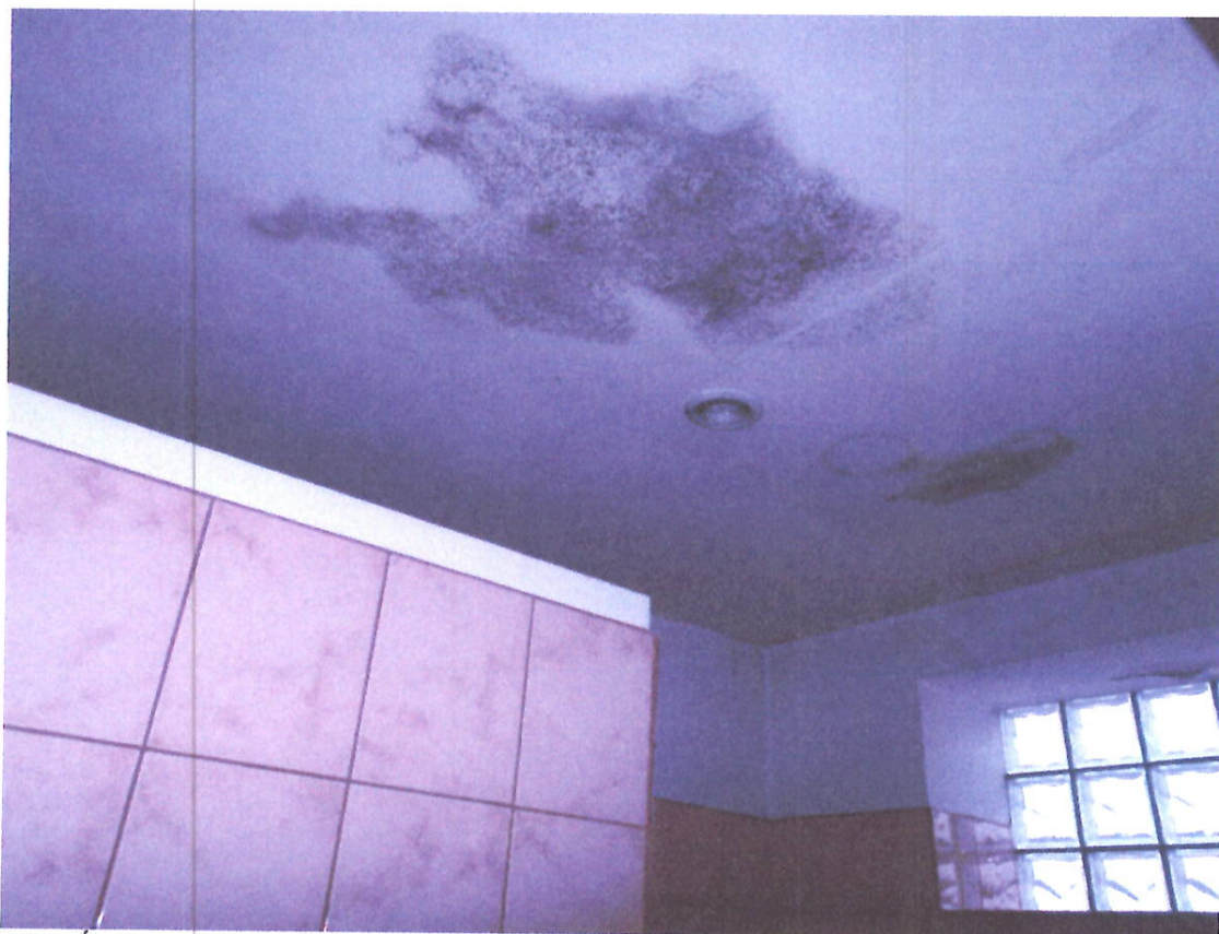
Fot. 7 Ślady przemarzania i zawilgocenia na ścianie i suficie w sanitariacie;
