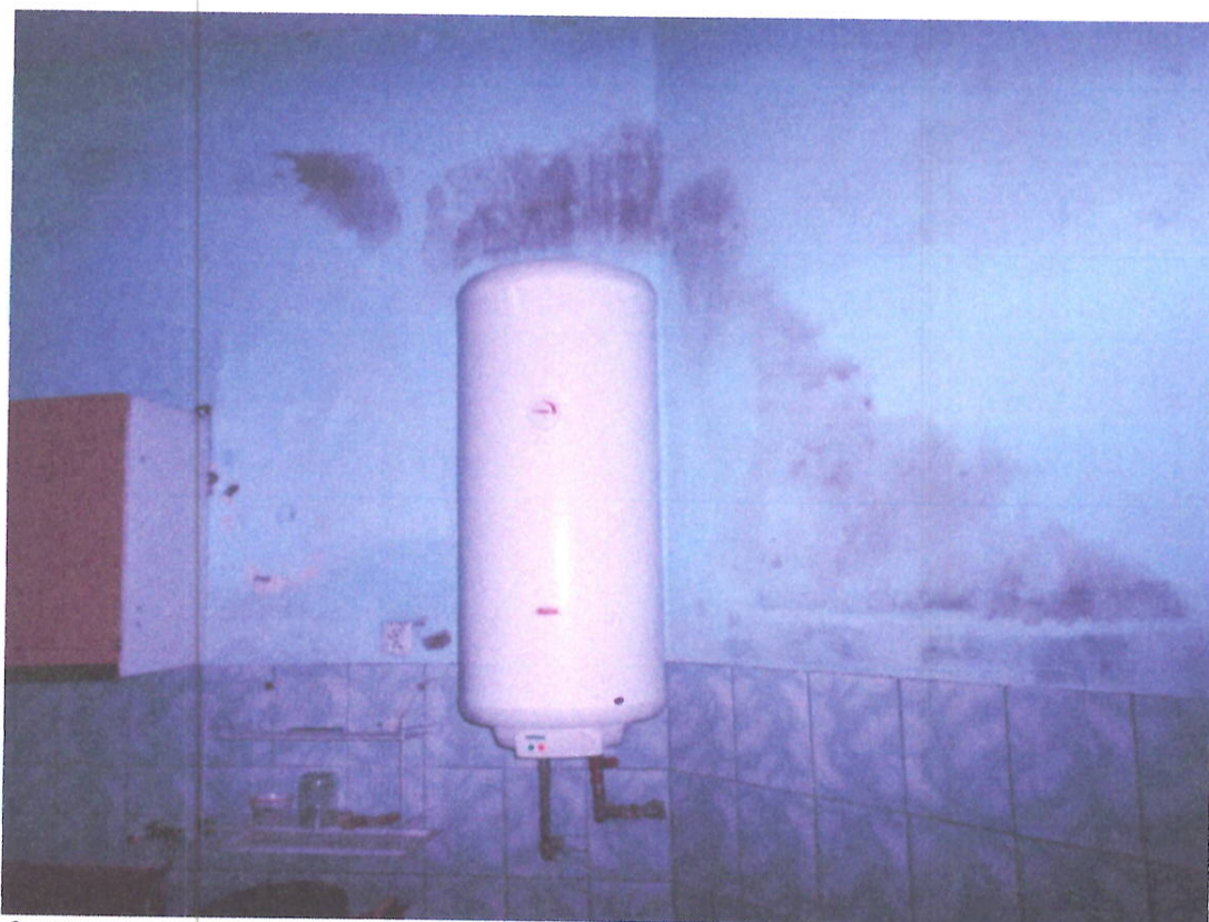
Fot. 8 Zabrudzona i zagrzybiona ściana w pomieszczeniu kuchennym.
