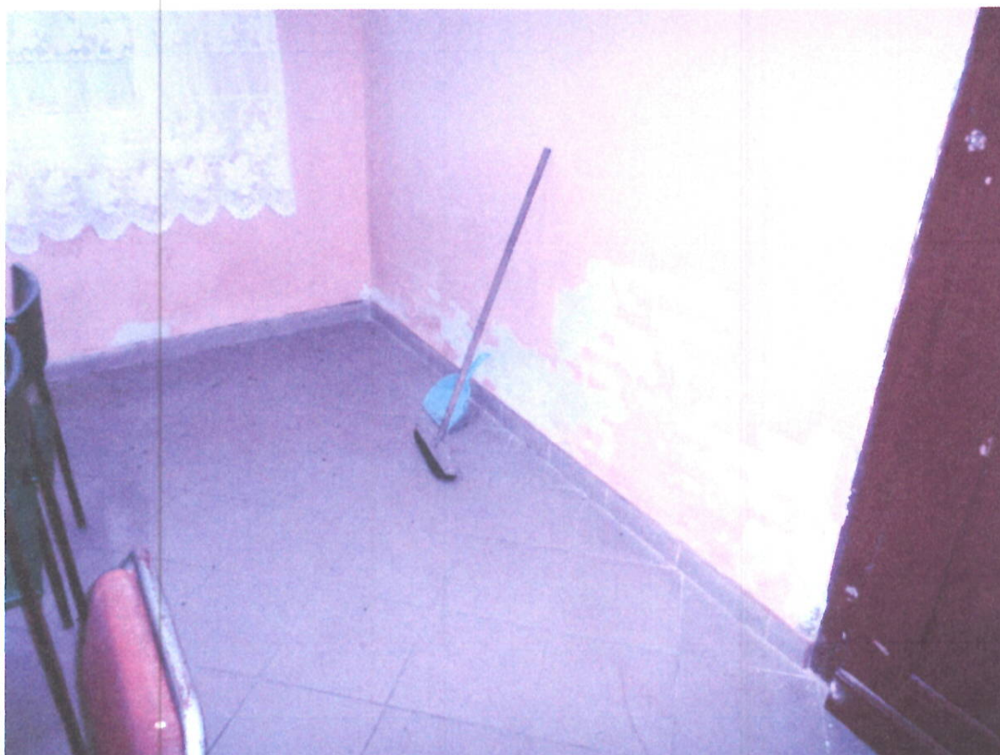
Fot. 6 Ślady zawilgocenia na ścianie, złuszczenie powłoki malarskiej w sali głównej;
