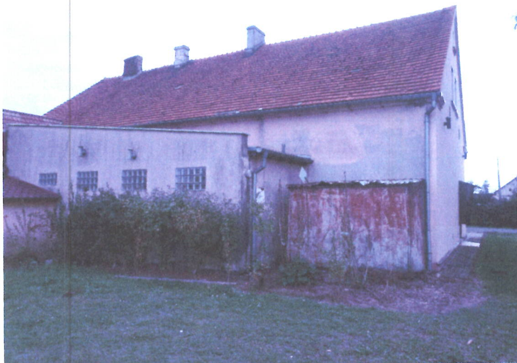
Fot. 4 Uszkodzony komin nad połacią dachową; nie ma możliwości sprawdzenia drożności komina ze względu na brak dostępu na poddasze i dach budynku; elewacja tylna z powłoką malarską zabrudzoną i wytartą traci kolorystykę;
