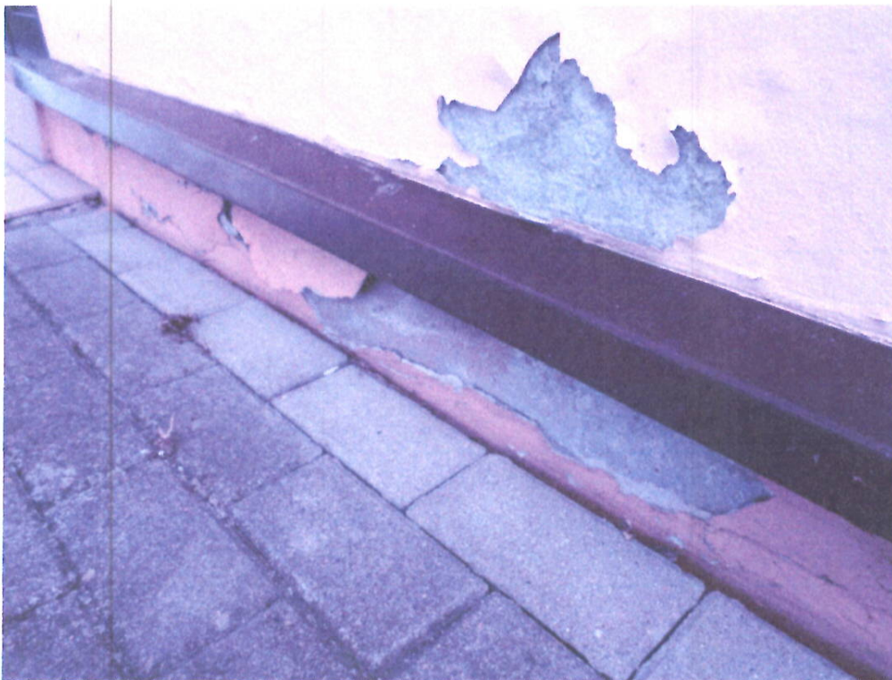
Fot. 1 Elewacja w dolnej części przygruntowej zawilgocona, z uszkodzonym tynkiem i powłoką malarską.
