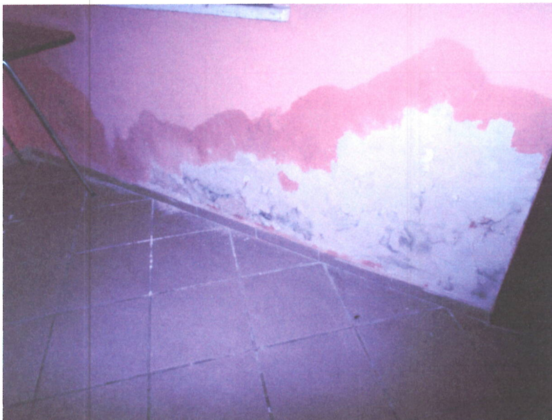
Fot. 5 Powłoka malarska od strony posadzki zniszczona, ze śladami zawilgocenia.
